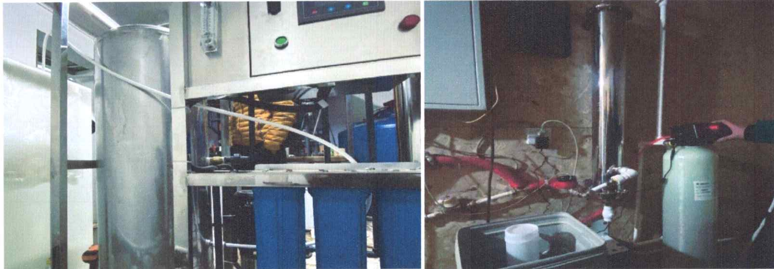
9.7 Цэвэршүүлэх төхөөрөмжийг ус хангамжийн эх үүсвэрт суурилуулав.
